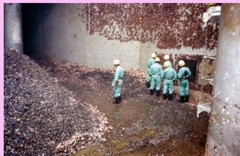
発電所取水管内に付着した汚損生物
