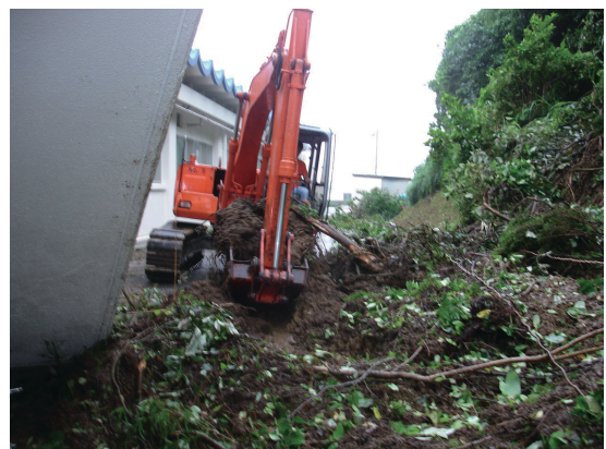
本館西側の土砂や樹木の撤去作業
