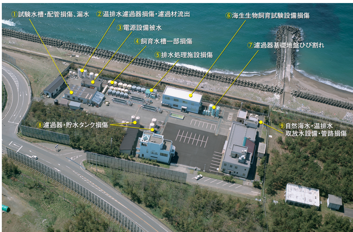
実証試験場の被害概要
