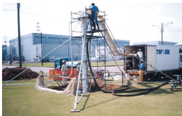
ライナーの反転挿入作業風景
