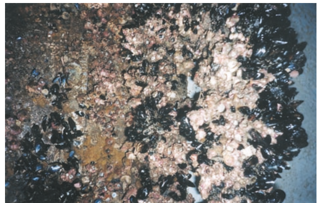
壁面に付着したアカフジツボ、ムラサキイガイなど
