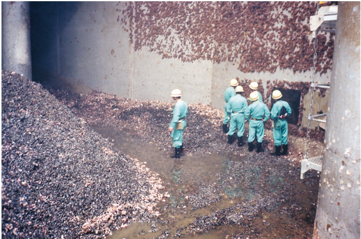
発電所取水管内に付着した「汚損生物」, 2001年4月に撮影
