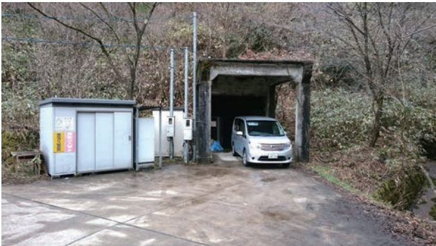
トンネルの出入り口
