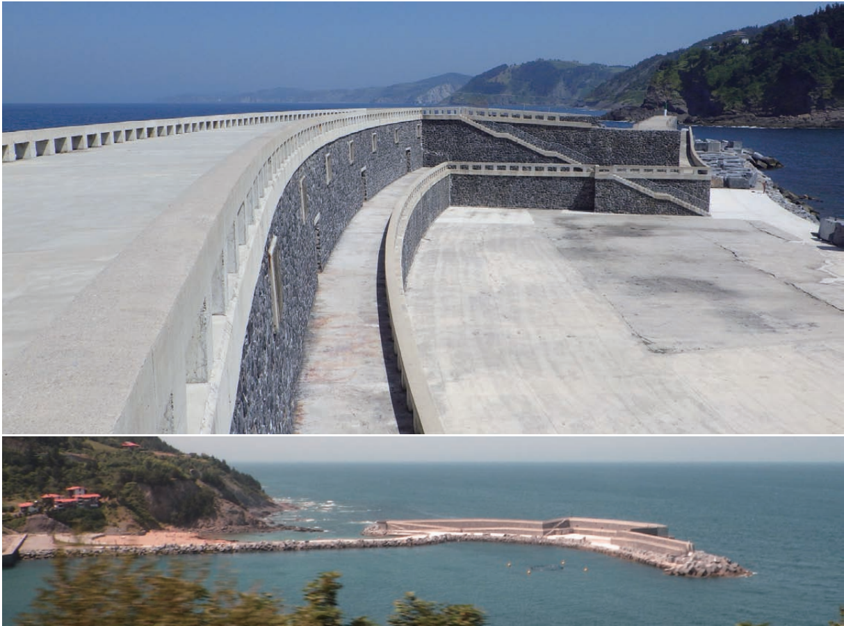
スペイン国ムトリク発電所(上:防波堤に建設された発電施設,下:施設遠景)
