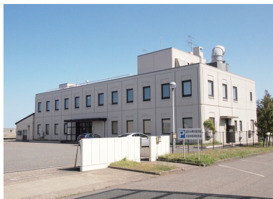
実証試験場本館
