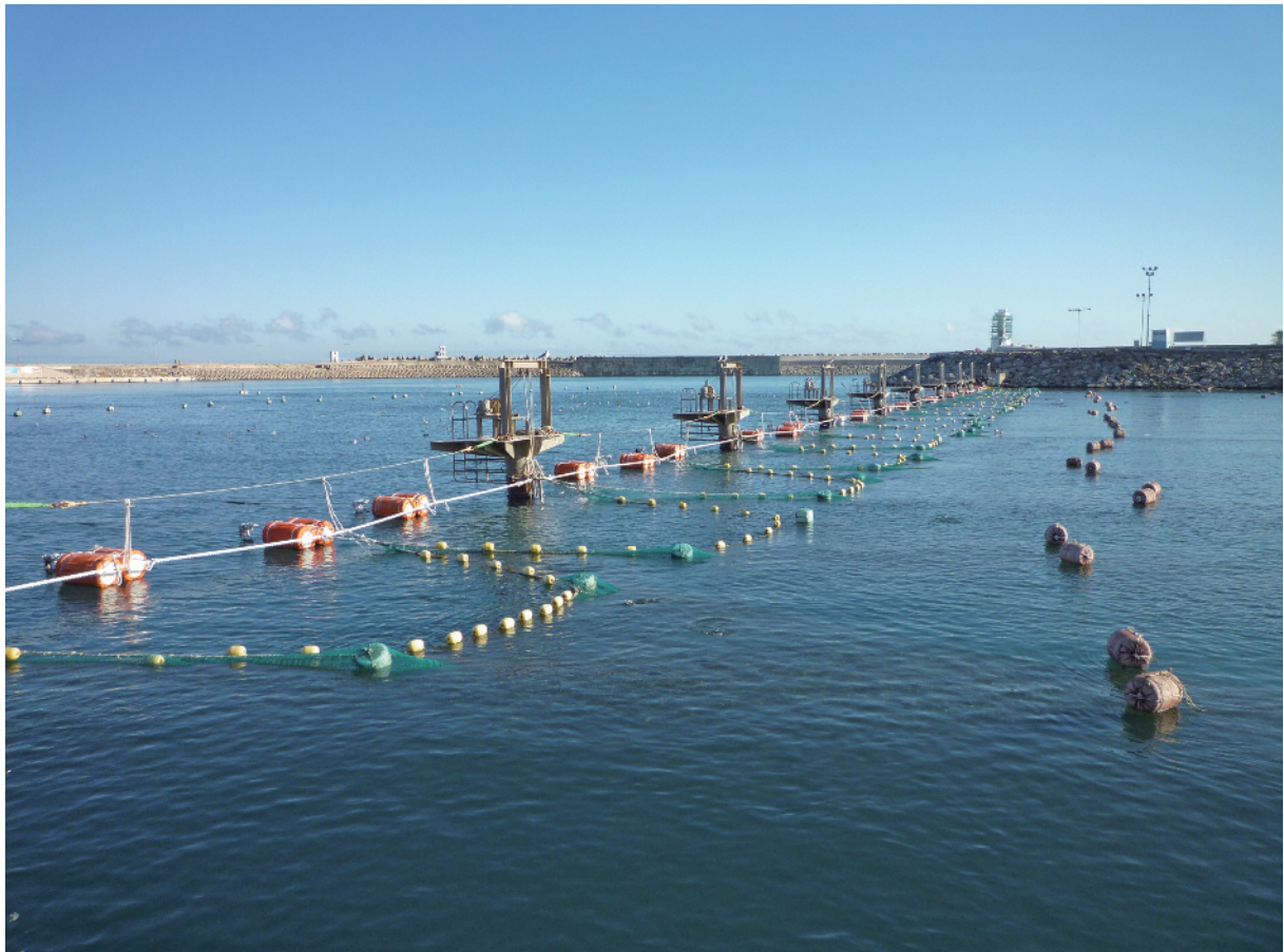
韓国蔚珍(ウルチン)原子力発電所の取水口(クラゲ類迷入防止網)
