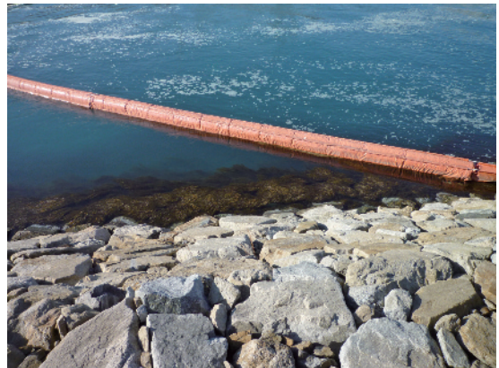
放水口側の泡防止策と護岸の海藻類
