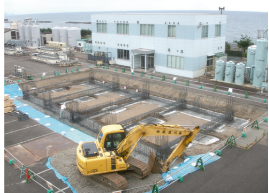
応用生態試験施設の基礎工事
