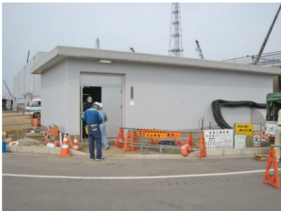
第1温海水ポンプ室の復旧工事
