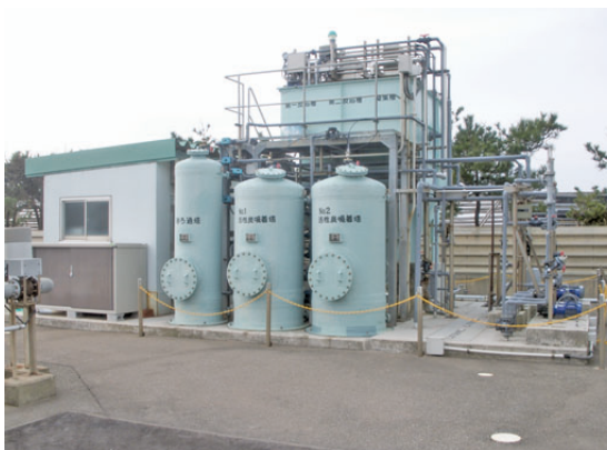
修理した排水処理施設
