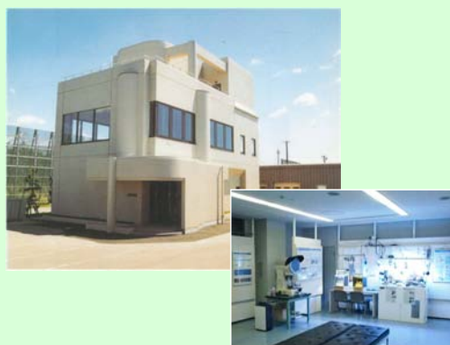
温排水資料展示館 （実証試験場）
