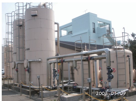
応急修理した濾過装置
