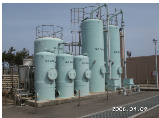
修理した濾過装置
